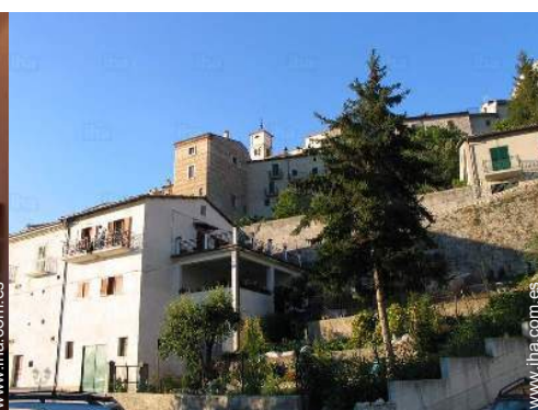
vista de conjunto
