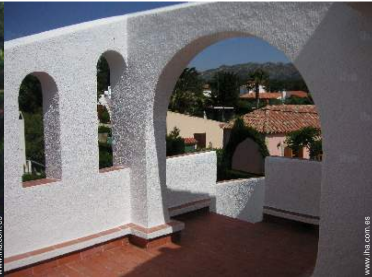
vista desde la azotea
