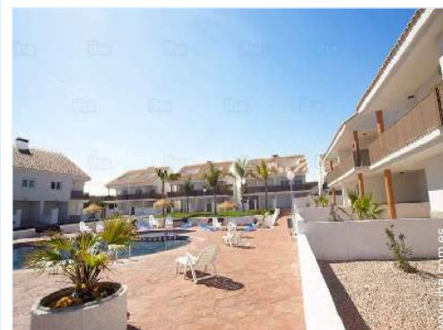
vista de conjunto
