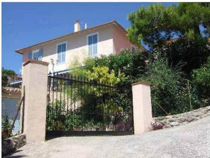
vista de conjunto
