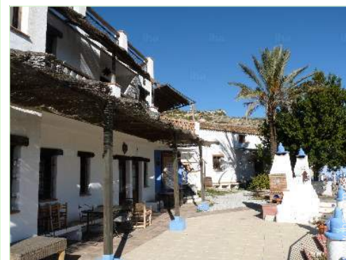
vista de conjunto
