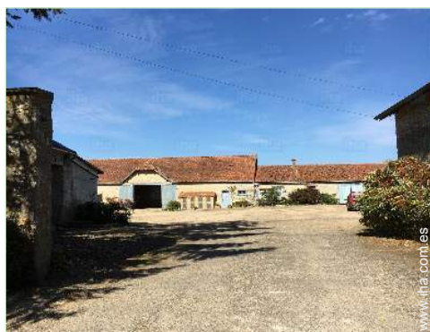
vista sobre el patio
