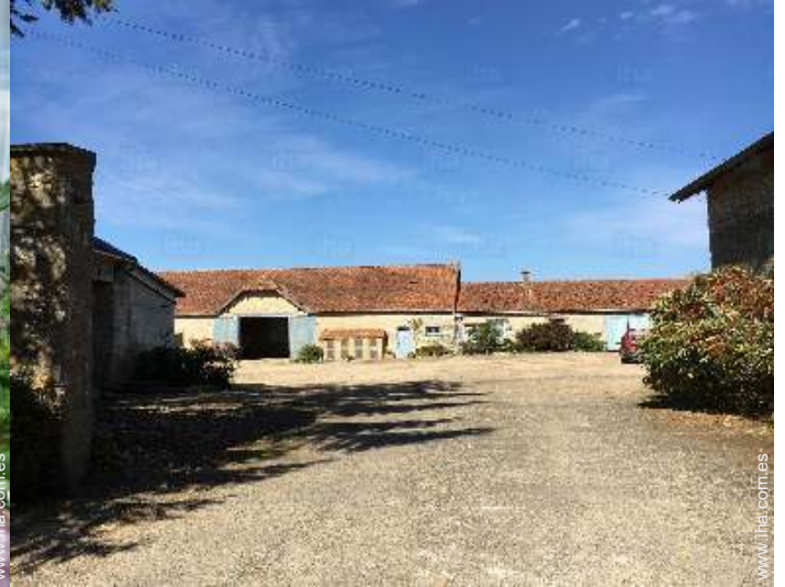
vista sobre el patio
