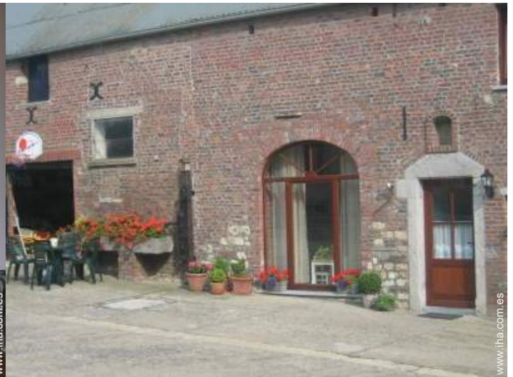
vista de conjunto
