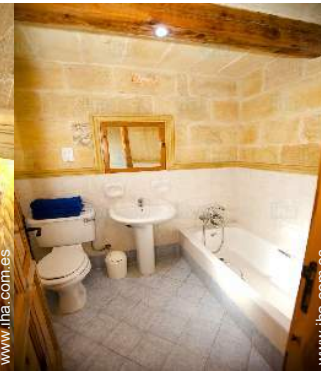
cuarto de baño
